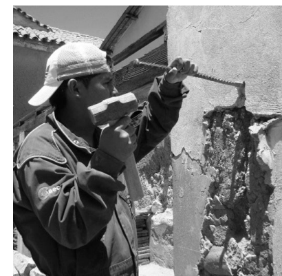
Retiro de revoque de cemento. Convento de Santa Teresa – Sucre – Chuquisaca, Bolivia
