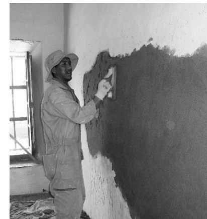
Restitución de revoque de cal y arena. Celda del Claustro del Convento de Santa Teresa – Sucre – Chuquisaca, Bolivia
