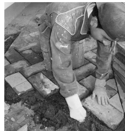
Restitución de piso de ladrillo desgastado. Claustro de Santa Teresa - Sucre - Chuquisaca, Bolivia
