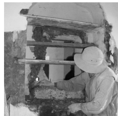
Liberación de muros de ladrillo que una vez retirado se identifica una alacena.
