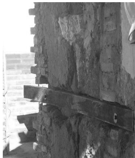
Consolidación de muro de adobe con llaves de madera y muros de ladrillo. Ex Hogar Beltrán – Sucre – Chuquisaca, Bolivia
