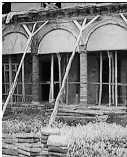
Apuntalamientos. Palacete de la Florida - Chuquisaca, Bolivia
