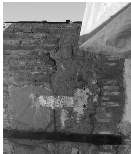
Consolidación de muro de adobe con llaves de madera y muros de ladrillo. Ex Hogar Beltrán – Sucre – Chuquisaca, Bolivia
